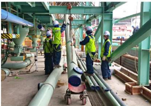
7. #1 "A" CASING FLY ASH 이송배관 설치
