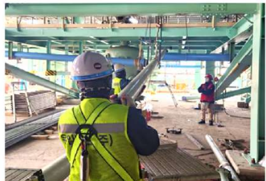
8. #1 "A" CASING FLUIDIZING 배관 설치
