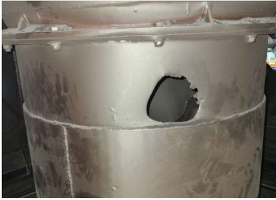
1. Extension Pipe 교체 전
