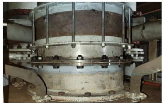
6. Center Feeder 단관 Pipe 조립
