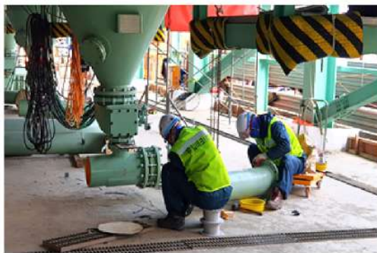
3. #1 "A" CASING CIA PIPE 설치
