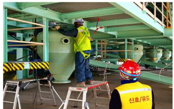
4. Air lock feeder 설치
