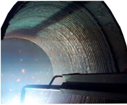
파이프 내부 초경 용접
