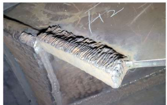
4. 미분기 내 마모부 초경용접 후
