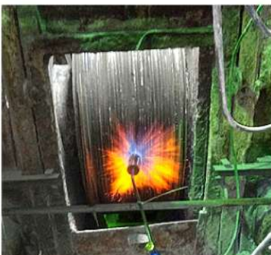
용접 전 예열 작업
