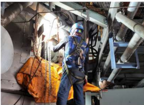
7. Mill Side Manhole 보강작업
