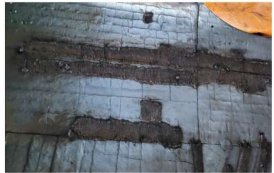
2. 미분기 내 마모부 초경용접 후
