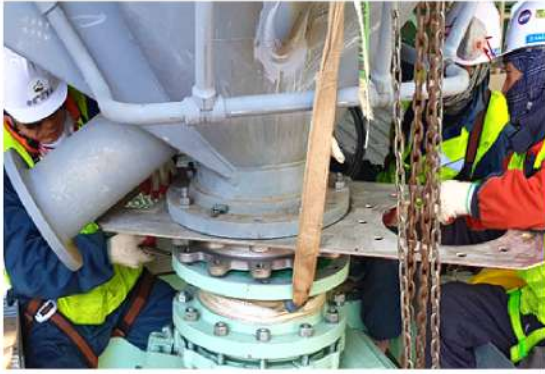
1. Air lock feeder 설치
