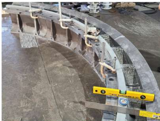
Vane 시범 설치
