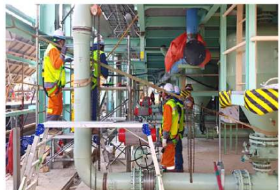
8. #1 "A" CASING FLY ASH 이송배관 설치
