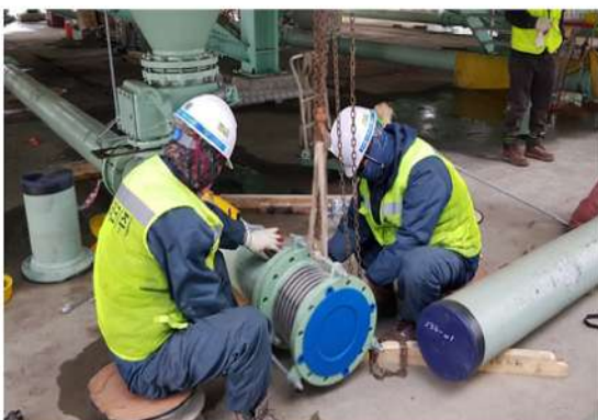
7. CIA Pipe 설치
