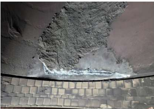
5. Outlet Pipe 내부 보강용접전
