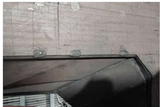
8. 미분기 내 마모부 초경용접 후
