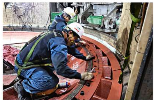
Inner Segment Vane 설치
