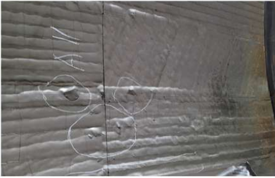
1. 미분기 내 마모부 초경용접 전
