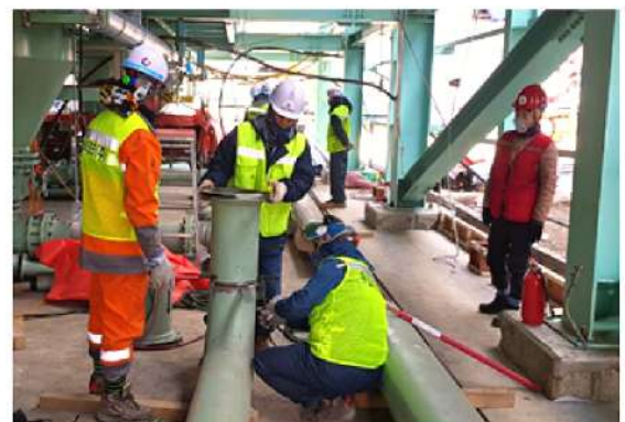
8. "B" Casing CIA Pipe 설치
