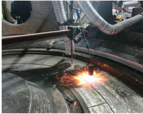
2. 육성시스템 설치 및 예열
