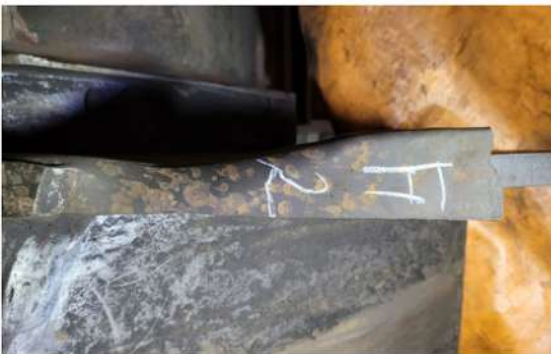
3. 미분기 내 마모부 초경용접 전
