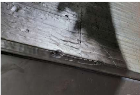
7. 미분기 내 마모부 초경용접 전
