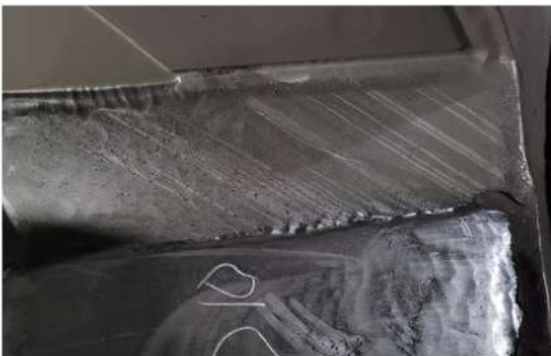
5. 미분기 내 마모부 초경용접 전
