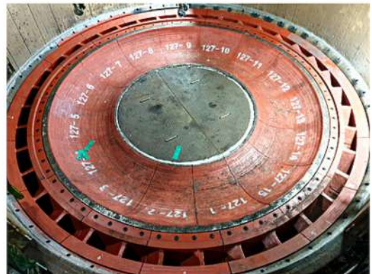
Inner Segment Vane 설치 완료
