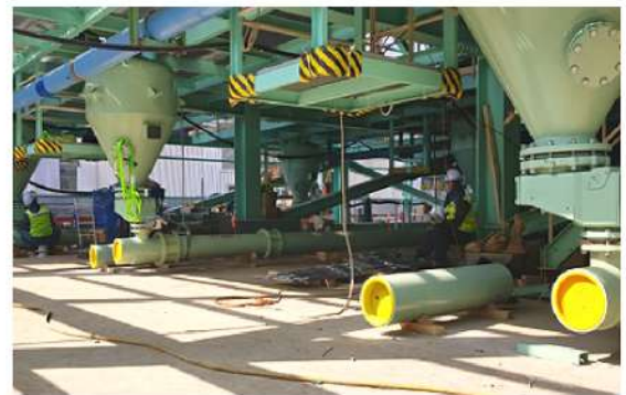
6. CIA Pipe 설치
