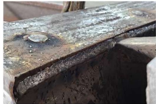
초경 Liner 용접
