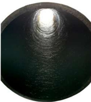
파이프 내부 초경용접 완료
