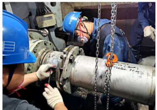
4. Coupling 및 shaft 조립
