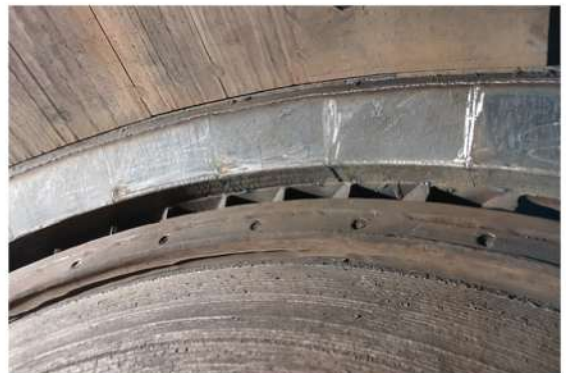
8. Armour Ring 설치 완료
