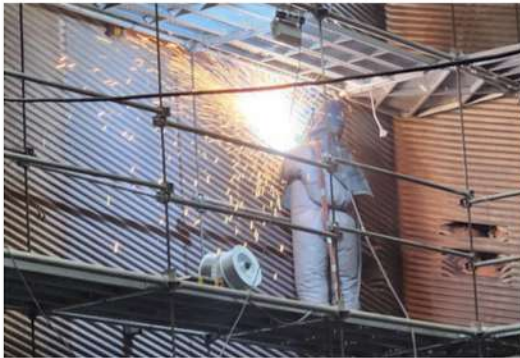
4호기 #14 용사코팅 작업
