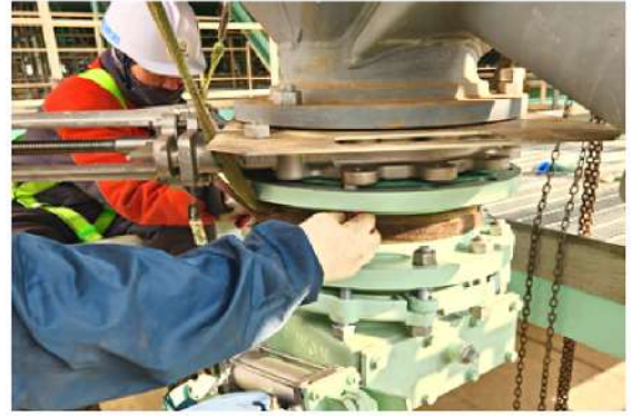
2. Air lock feeder 설치
