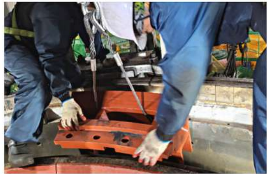
Inner Segment Vane 설치
