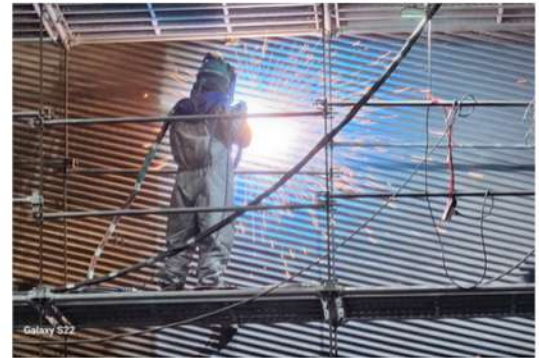
4호기 #14 용사코팅 작업
