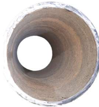
파이프 내부 초경용접 완료
