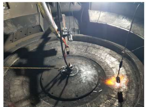
6. 육성시스템 설치 및 예열
