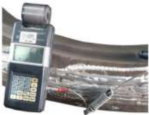
07 용접 후 경도 측정
