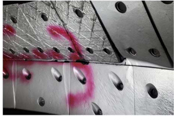
2. 정비전 Liner 상태
