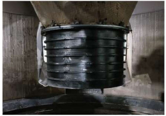
2. Extension Pipe 교체 후
