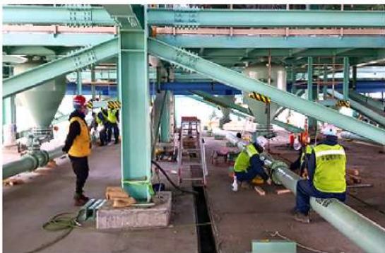
5. CIA Pipe 설치
