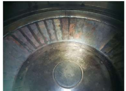
6. 신작 세그먼트 설치
