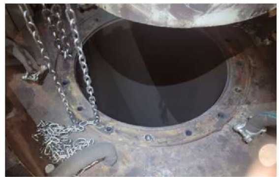
4. Center Feeder 단관 Pipe 분해 후
