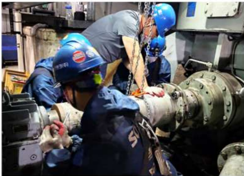
3. Coupling 및 shaft 조립
