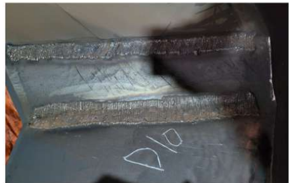
6. 미분기 내 마모부 초경용접 후
