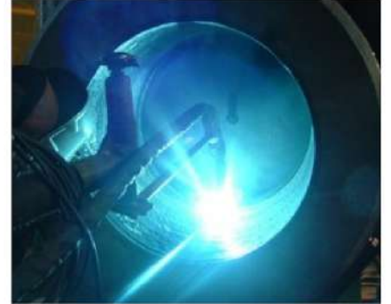
파이프 내부 초경 용접
