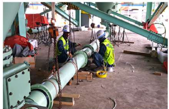
4. #1 "A" CASING CIA PIPE 설치
