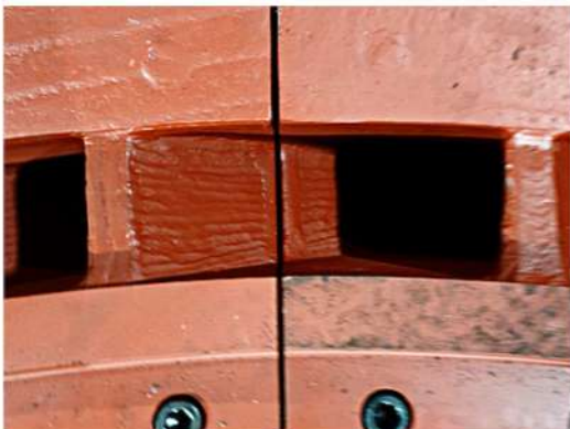
Inner Segment Vane 설치 확인
