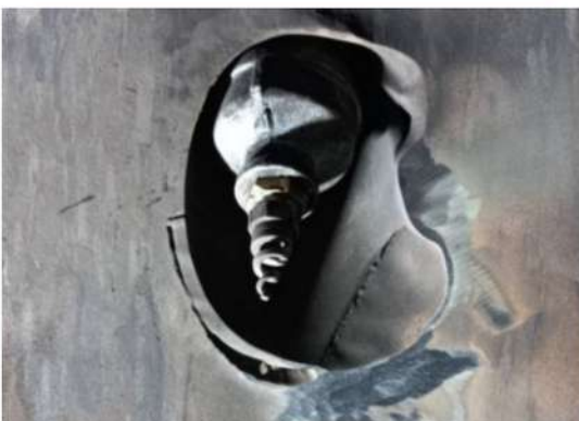
7. Mill Side 소화수 라인 보수 전
