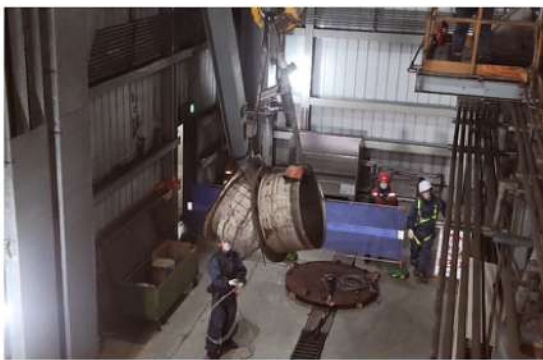
3. Center Feeder 단관 Pipe 인양
