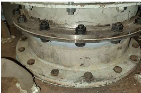
5. Center Feeder 단관 Pipe 조립
