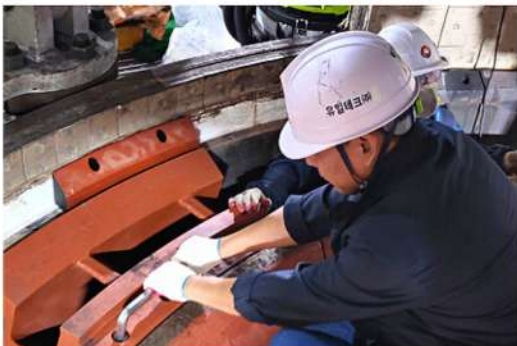
Inner Segment Vane 설치
